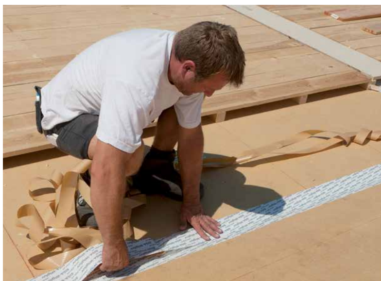
Prověření odolnosti proti větru: DHF desky představují bezpečný podklad i u střech s nízkým sklonem.
